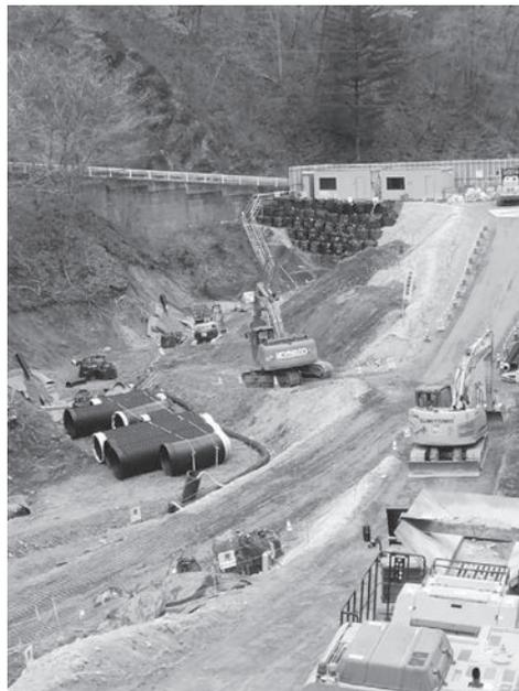
る為の仮設道路工事も進行しています。目視はできませんが大雨時や工事中に出る濁り水対策として仮設沈砂池
