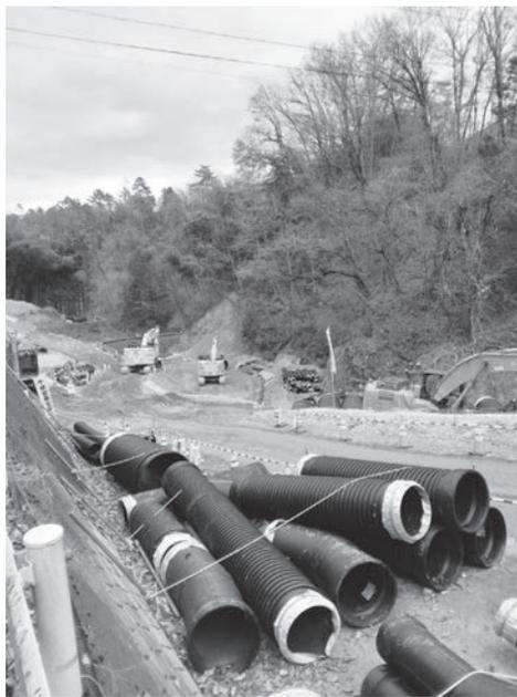
火沢地区におけるリニア中央新幹線トンネル掘削発生土埋立て工事が8月より着手となりました。現在は村道1号と火沢川の交差する付近をヤードとして下流側の樹木の伐採、河川の軟弱地盤の剥ぎ取りと並行し径1mほどもある地下排水菅が設置されつつあります。埋め立て予定地の末端は擁壁や地下排水を貯める為の沈砂池が作られますがそこへ到達す
