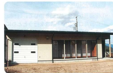
4 大規模災害に対応するための衛星携帯電話を、各詰所・役場・いきいきらんどに設置、さらに住宅火災を素早く感知できる火災警報器の全戸配布、消防団の第3分団詰所の完成により災害に強い村づくりへの体制作りが整いました。
