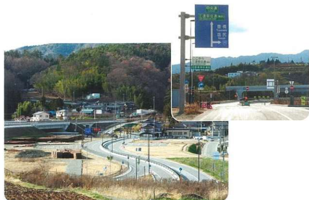
9 4月13日に天龍峡インターから飯田山本ジャンクションまでの三遠南信自動車道が開通し、下條村の中心部から約6分で天龍峡インターに行けるようになり、非常に便利になりました。
