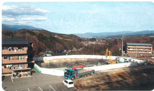
10 今回第10メゾンコスモス横へ雇用対策向け集合住宅15戸を建設しております。今年3月15日には完成の予定です。
