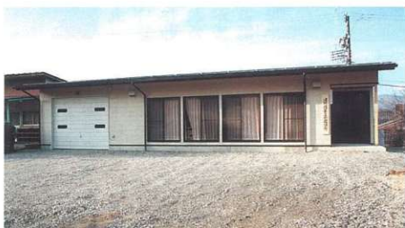
▲ 12月中旬 消防第三分団の詰所が中平集会所の隣に建設されました。地域防災施設の拠点として有効利用されるよう期待します。
