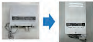
①外壁のV-ONUの交換作業
